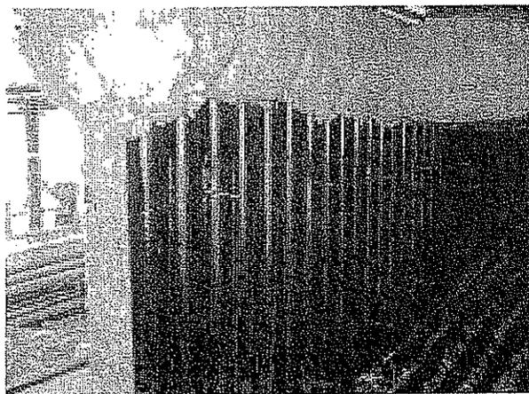
図 4-4-3 ボイラ水管保温例
